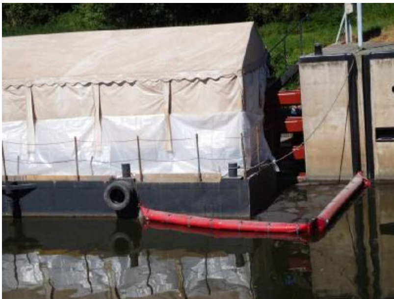
Ukázka norné stěny se zachycenými prachovými částicemi
