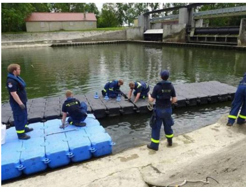
Ukázka využitelné provizorní plovoucí desky "JetFloat"
